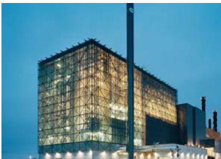
Gästadsverket waste incineration plant in Linköping, Sweden
